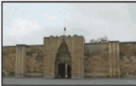
Aksaray Suluhan Kervansarayı
